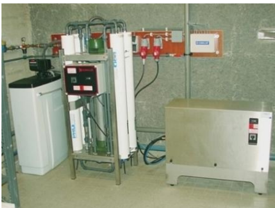
Ontharder 12, Osmose en Boosterpomp Plus
