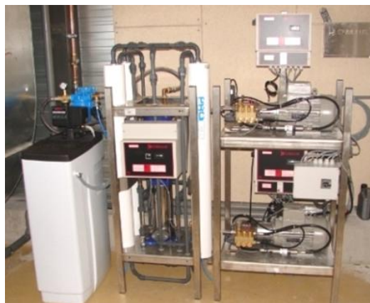
Ontharder 30, Osmose en Boosterpomp Min Duo
