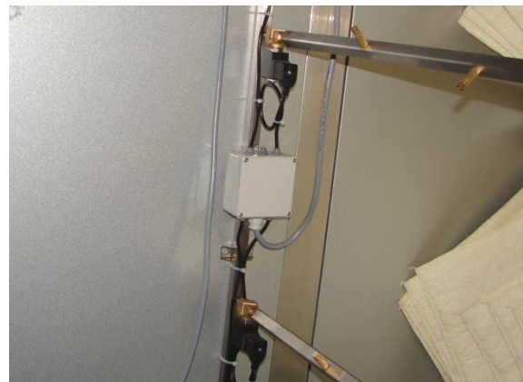
Lans met magneetklep binnen de LBK.
